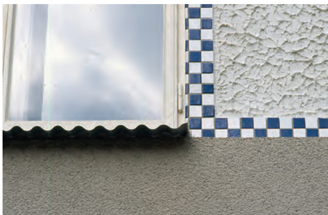
Abb. 5: Sanatorium Purkersdorf, Detail nach Restaurierung, 1996
