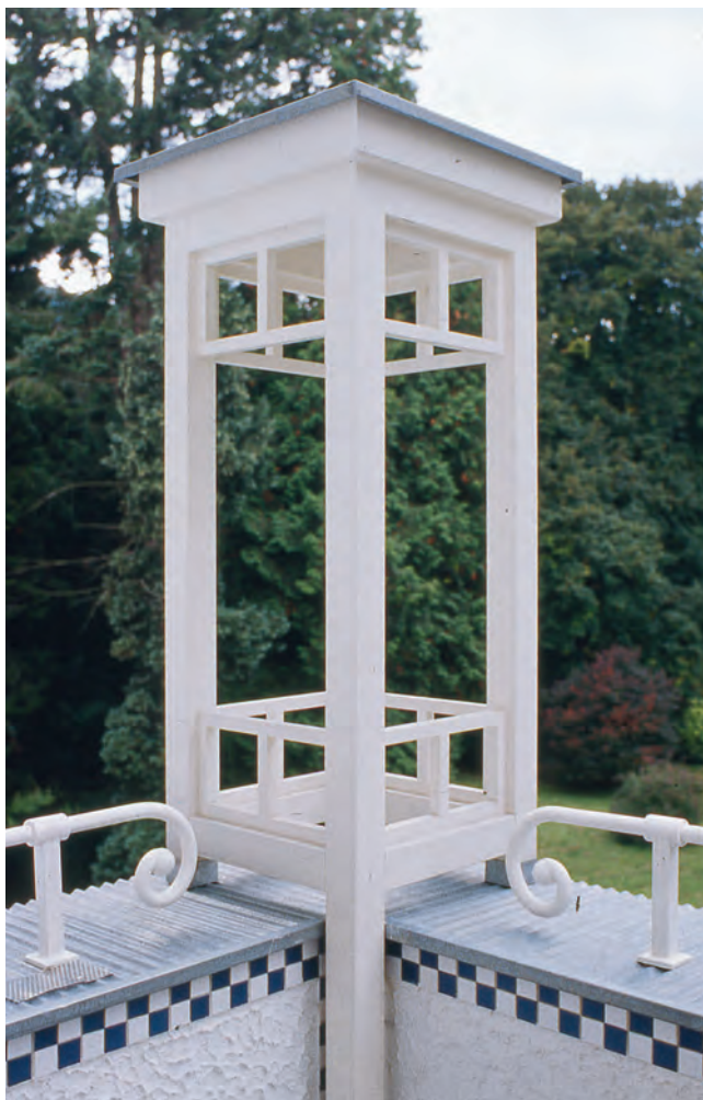
Abb. 6: Sanatorium Purkersdorf, Detail nach Restaurierung, 1996
